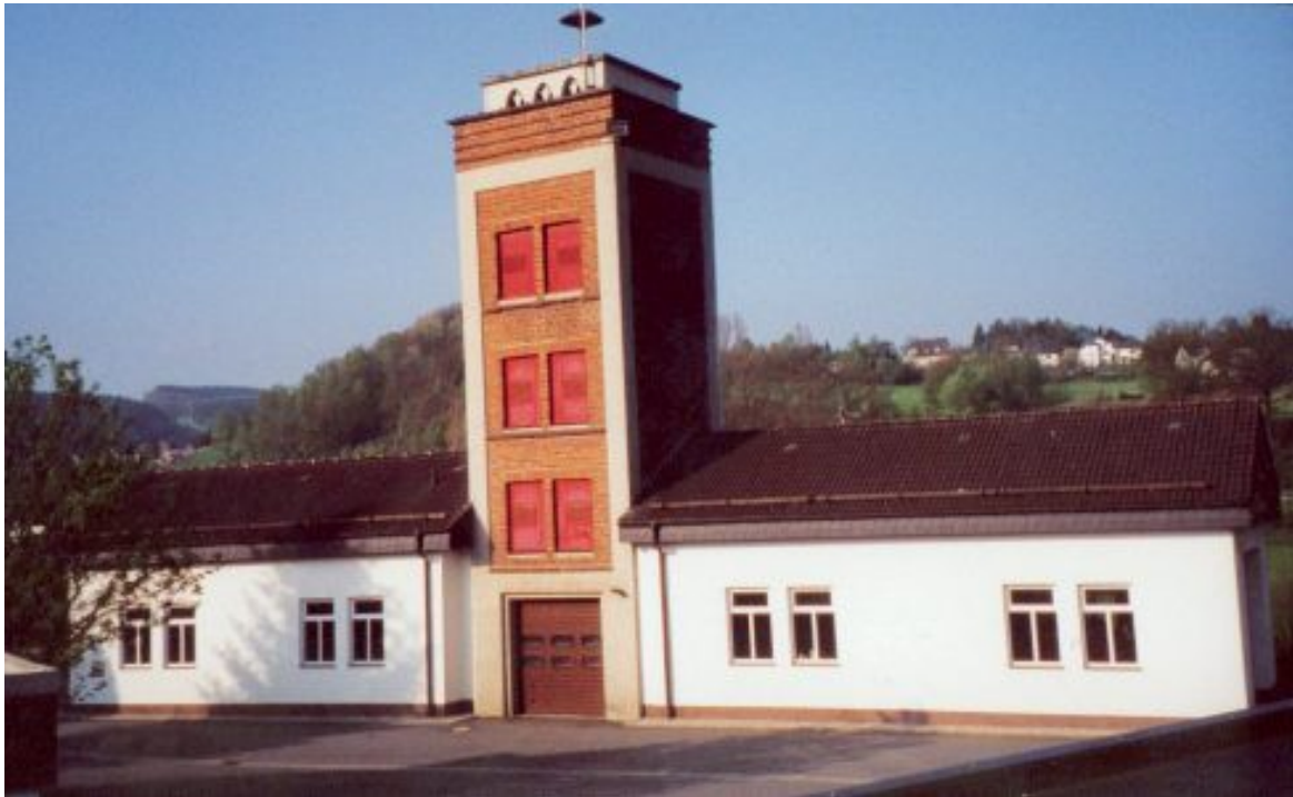
Der Grevenbrücker Feuerwehrturm 2010 Foto: www.feuerwehr-grevenbrueck.de
