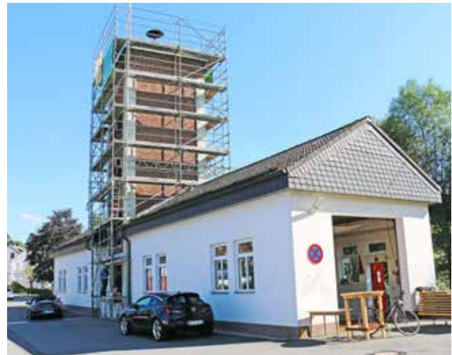
Außenrenovierung mit eingerüstetem Turm.
