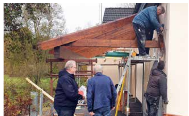
Bau der Überdachung zur Brennholz-Lagerung.
